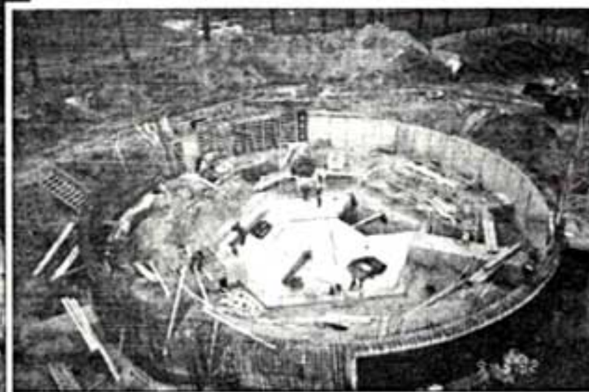
Deze foto bewijst hoe verrassend slim de buitenmantel van deze 30000 ton wegende toren eigenlijk is. In het midden de aanzet van de 197 m hoge centrale liftkoker.
