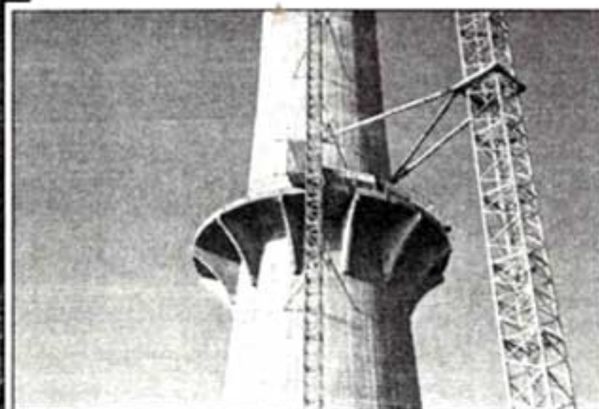
Platformen en consoles: een combinatie van prefabricatie en ter plaatse gestort beton.
