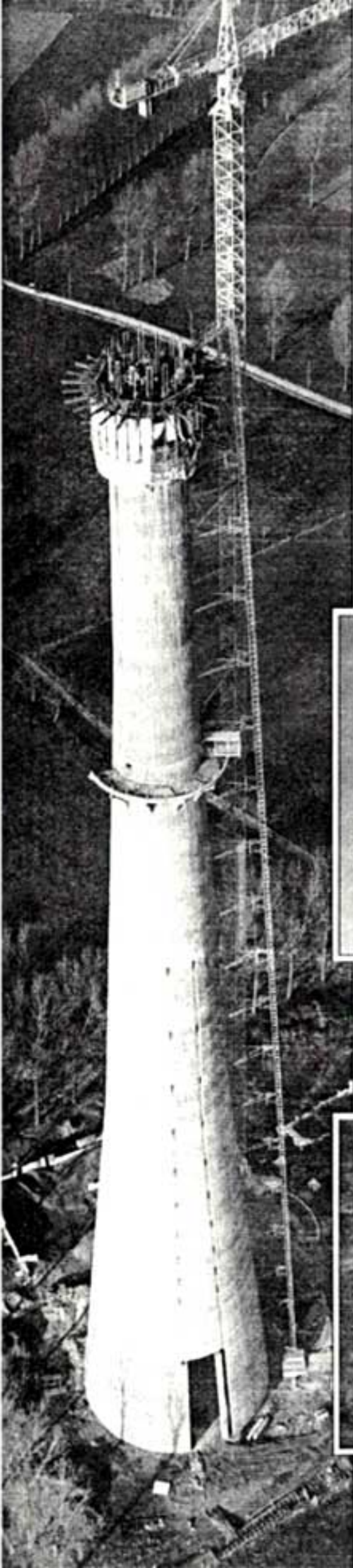
Een slanke betonnen kolos in het Vlaamse Brabantse landschap de nieuwe BRTN-zendmast te Sint-Pieters-Leeuw. Het ook op omhoogste-niveau: Liebherr-torenkruis.
