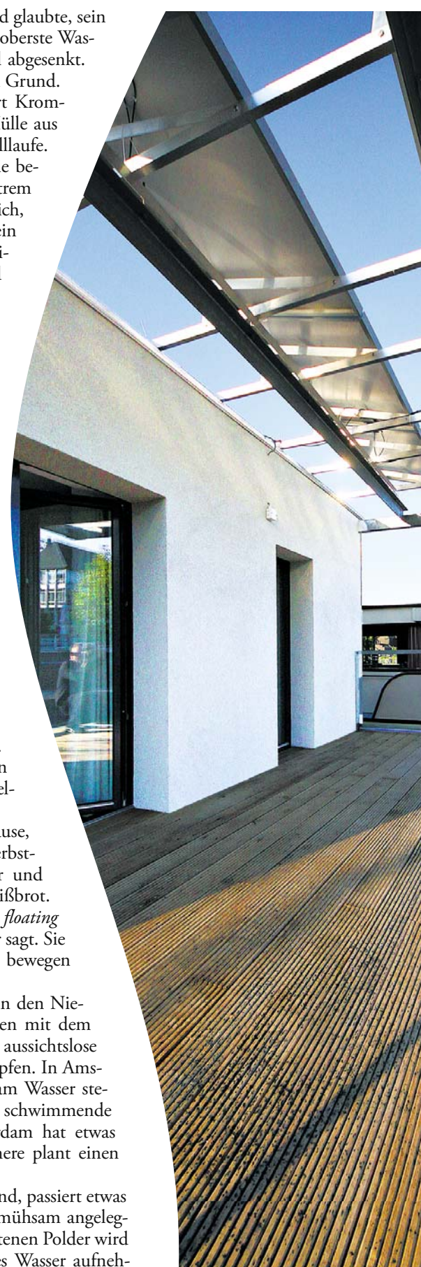
Solaranlage auf dem Dach
