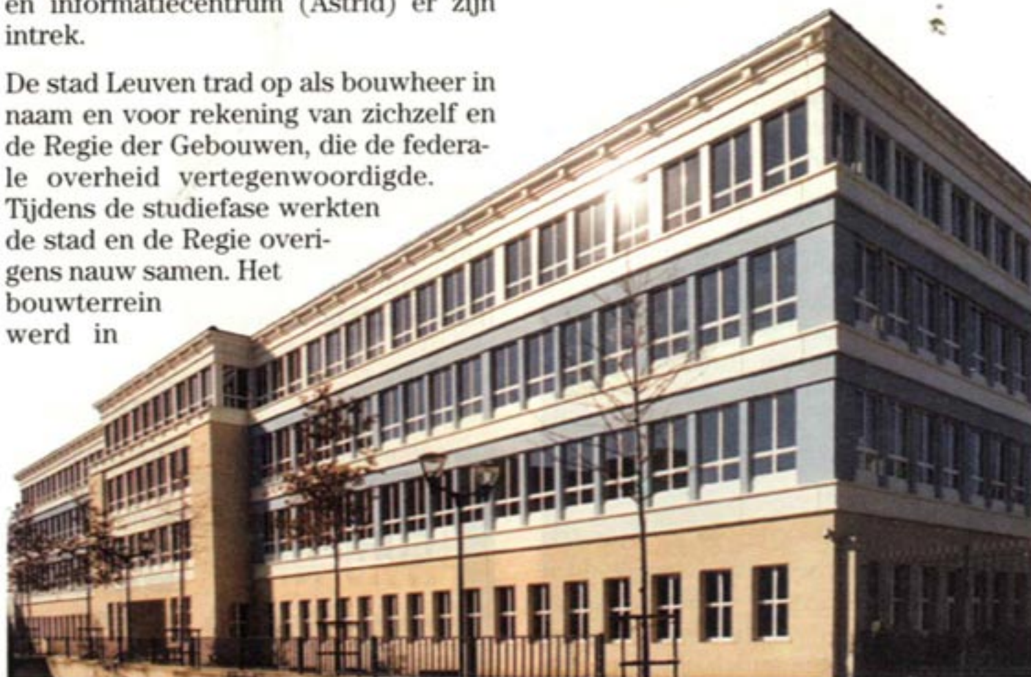
De gevelbekleding bestaat uit witte aluminium profielen en azuurblauw pleisterwerk.
