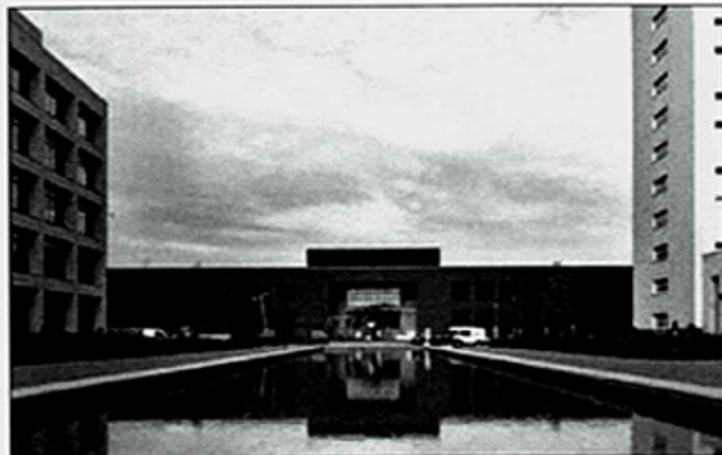
■ Het nieuwe SportPlaza-complex herbergt niet alleen een hal die plaats biedt aan ruim 3.000 toeschouwers, maar ook de grootste fitnesszaal van België en een competitiezwembad. (Foto RV)
